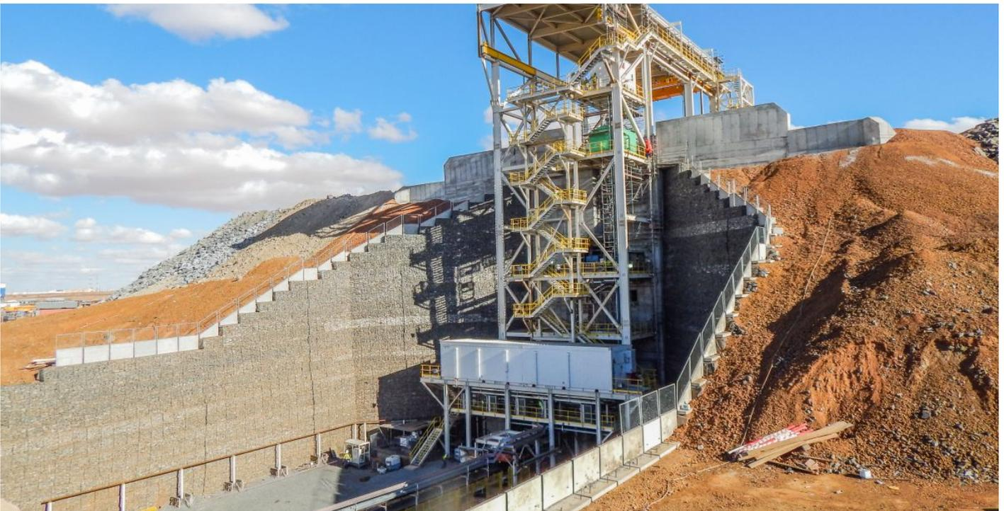
Terramesh System & Géogrilles de renforcement ParaLink
