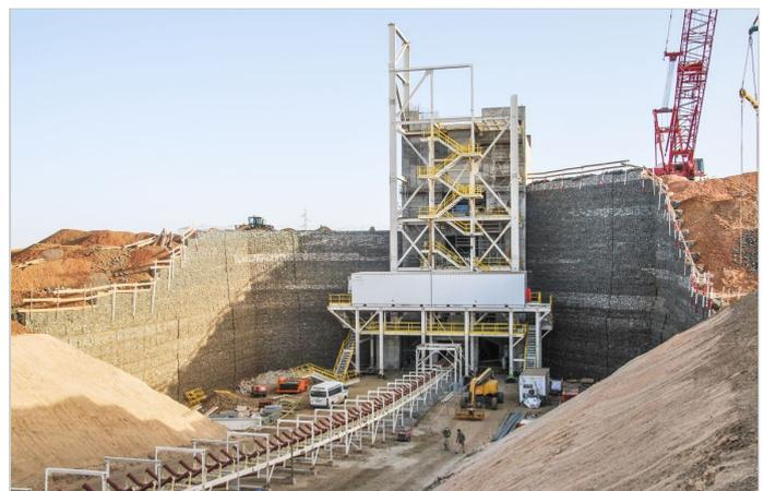
Terramesh System & Géogrilles de renforcement Paralink
