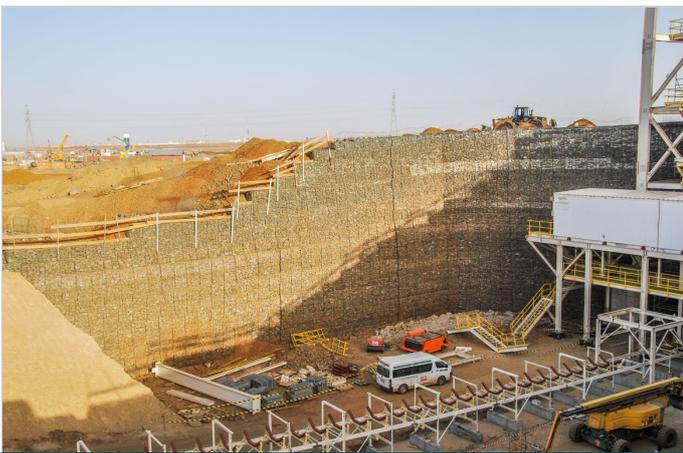
Terramesh System & Géogrilles de renforcement ParaLink
