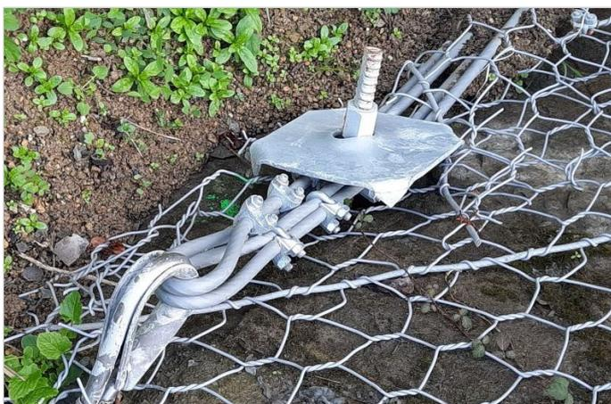
5. Placa HR Plate y anclaje de doble cable flexible T-FAST
