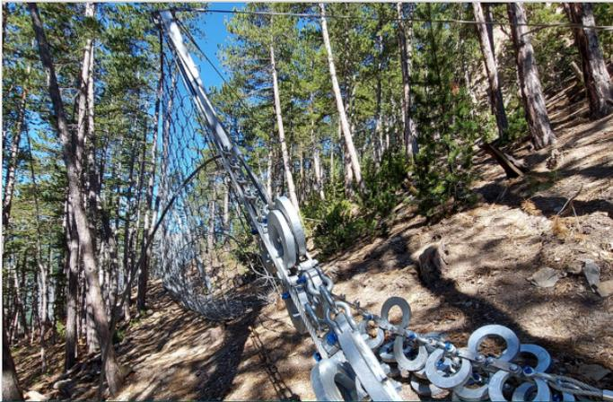
Écran pare-blocs RB2000 - détail des dissipateurs d'énergie
