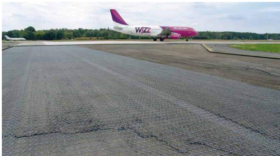
Obr. 1 Aplikácia RoadMesh pri rekonštrukcii letiska vo Vroclave, Poľsko
