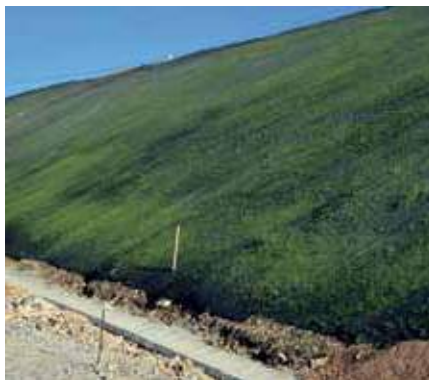
Obr. 5 Aplikácia georochože MacMat na svahu zárezu
