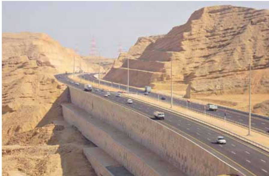
Obr. 1 Oporný vystužený múr na Muscat Southern Expressway v Ománe
