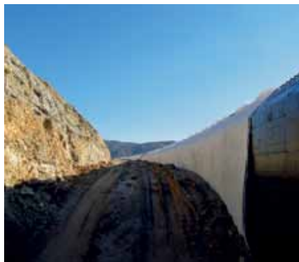
Obr. 4 Aplikácia drenážneho geokompozitu MacDrain na rube gravitačného múru
