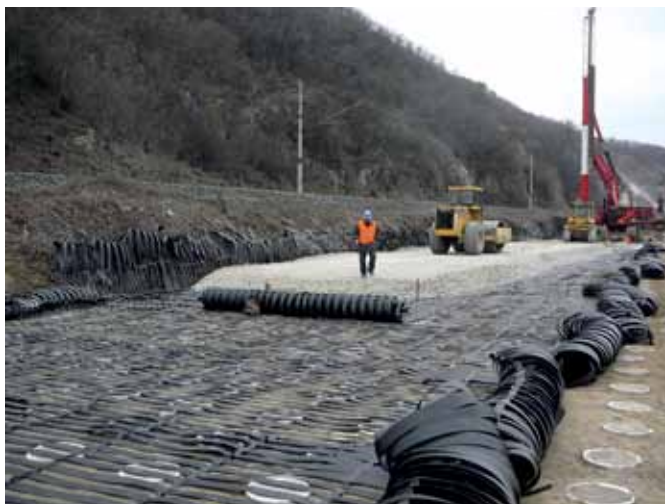
Obr. 2 Inštalácia geomreží ParaLink na hlavách pilót v bázе železničného násypu
