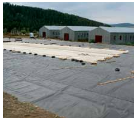
Obr. 6 Inštalácia geomembrány MacLine s ochrannou geotextíliou MacTex N.20
