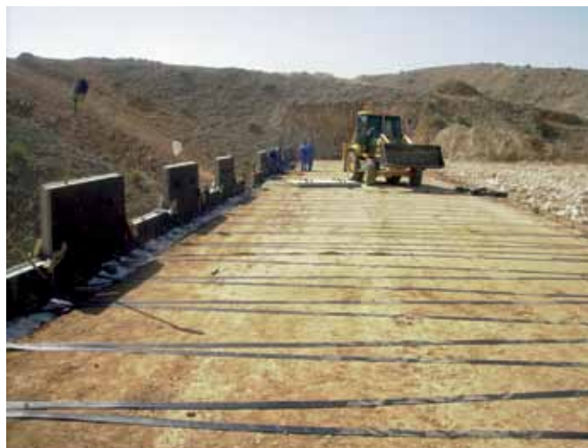
Obr. 3 Aplikácia geopásov ParaWeb a vertikálnych betónových panelov
