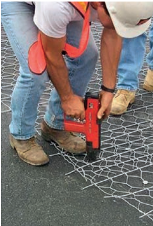
Fixovanie siete RoadMesh® nastrelovacími kotviacimi prvkami
