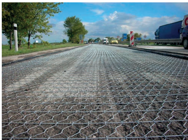
Aplikácia siete RoadMesh® na komunikácii R1 v úseku Trnava – Nitra
