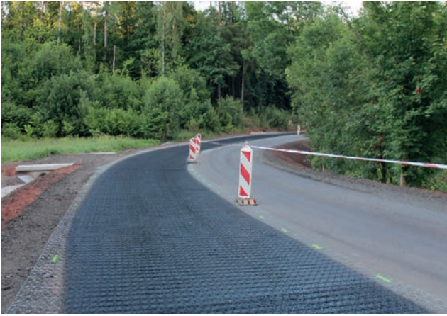
Aplikácia siete RoadMesh® na komunikácii I/16 Čistá u Horek
