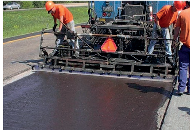
Fixovanie siete RoadMesh® emulzným mikrobercom
