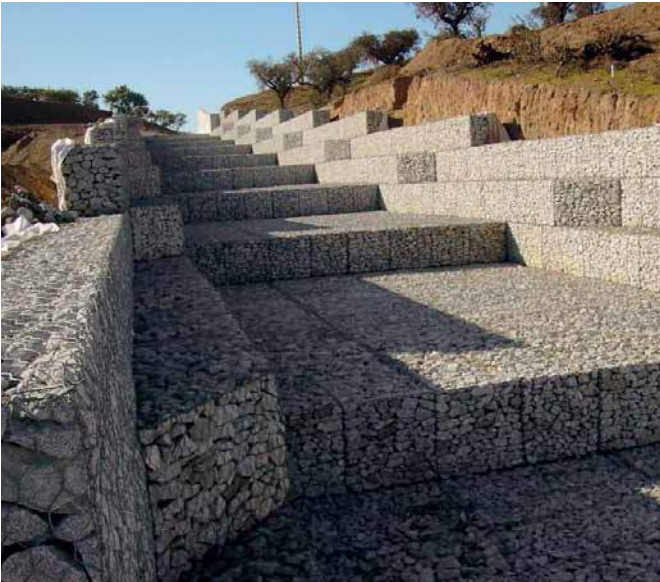
Príkladne zrealizovaná gravitačná gabionová konštrukcia
