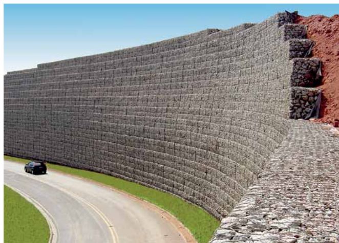
Príkladne zrealizovaná VHK s gabionovým lícom
