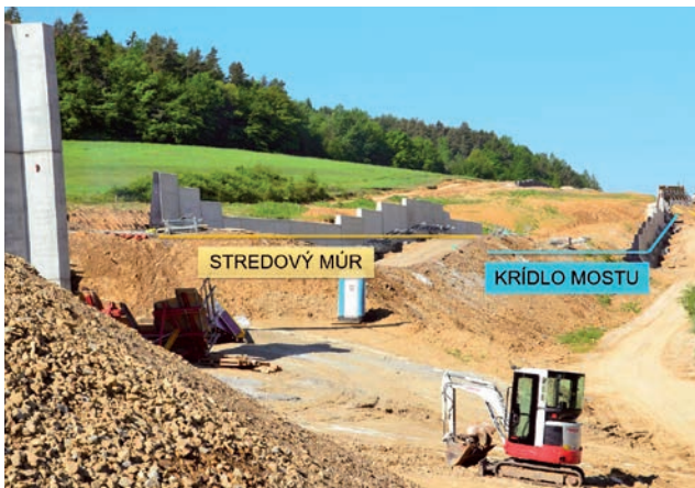
Obr. 2 – Pohľad na kotvený múr (1. stupeň) pri moste 213-00
