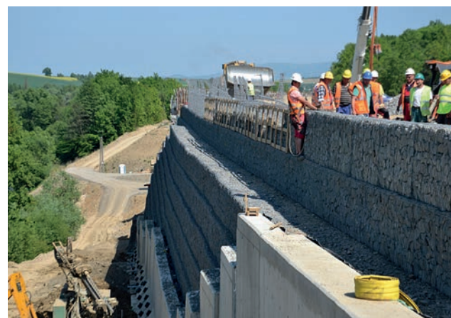
Obr. 5 – Pohľad na krídlo mostu zo systému Terramesh
