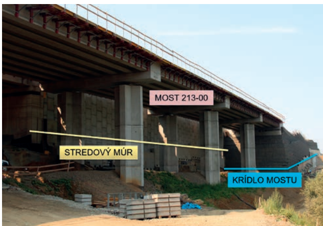
Obr. 9 – Celkový pohľad na most 213-00
