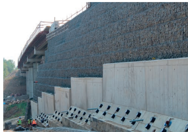
Obr. 6 – Pohľad na krídlo mostu zo systému Terramesh
