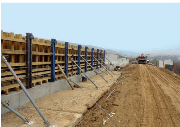
Obr. 3 – Výstavba kotveného múru (1. stupeň)
