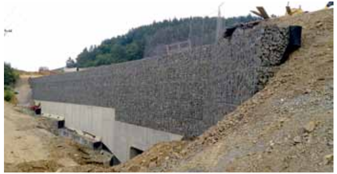
Obr. 8 Oporný múr Terramesh založený na kotvenom ŽB prahu – úsek 14A D1 Fričovce – Svinia
