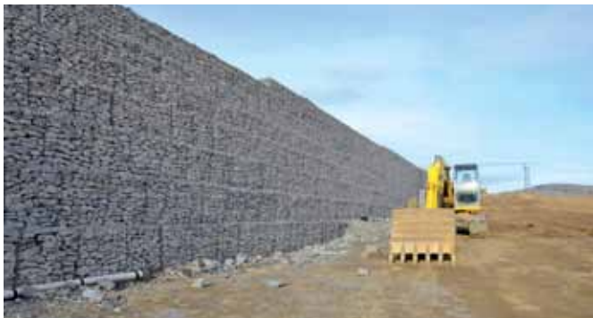
Obr. 4 Pohľad na oporný múr Terramesh na D1 Jánovce – Jablonov, II. úsek
