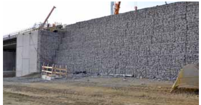
Obr. 5 Detail napojenia oporného múru Terramesh na mostnú oporu na D1 Jánovce – Jablonov, II. úsek
