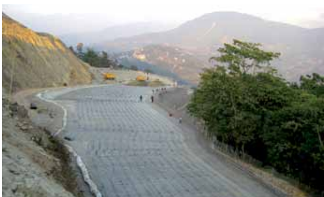
Obr. 9 Vystužená horninová konštrukcia s lícom Terramesh vo výstavbe – letisko Sikkim, India
