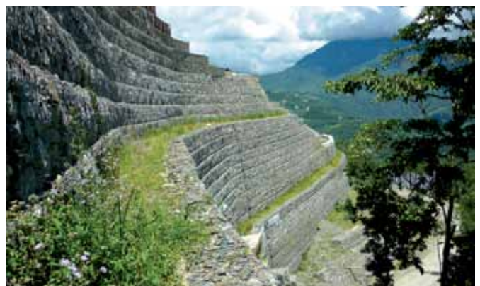
Obr. 10 Pohľad na spodnú časť vystuženej horninovej konštrukcie s lícom Terramesh vo výstavbe – letisko Sikkim, India
