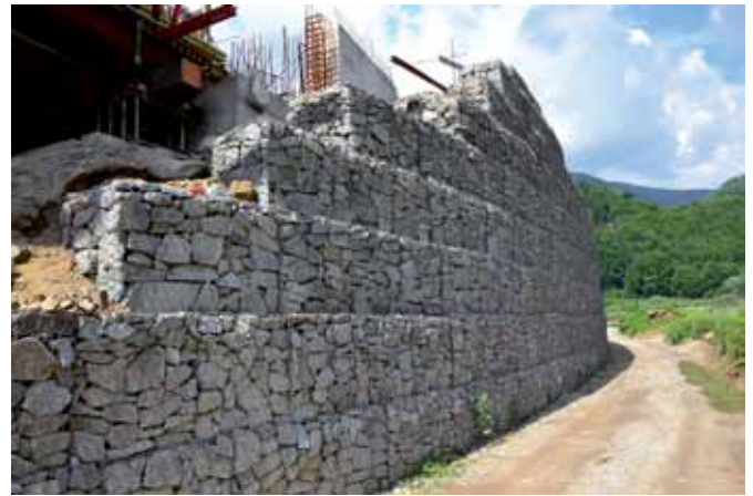
Obr. 3 Pohľad na objekt 231-00 vo výstavbe na D1 Dubná Skala – Turany
