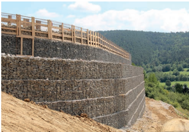
Obr. 4 – Obj. 202-00 opora 5 vo výstavbe
