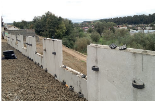
Obr. 11 – Úsek 15 obj. 100-00 Osadzovanie prvého radu panelov
