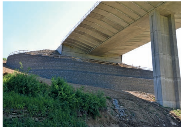
Obr. 5 – Pohľad na oporu 5 obj. 202-00
