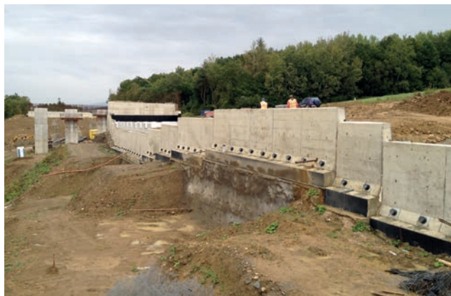
Obr. 10 – Úsek 15 obj. 100-00 Pohľad na kotevný múr
