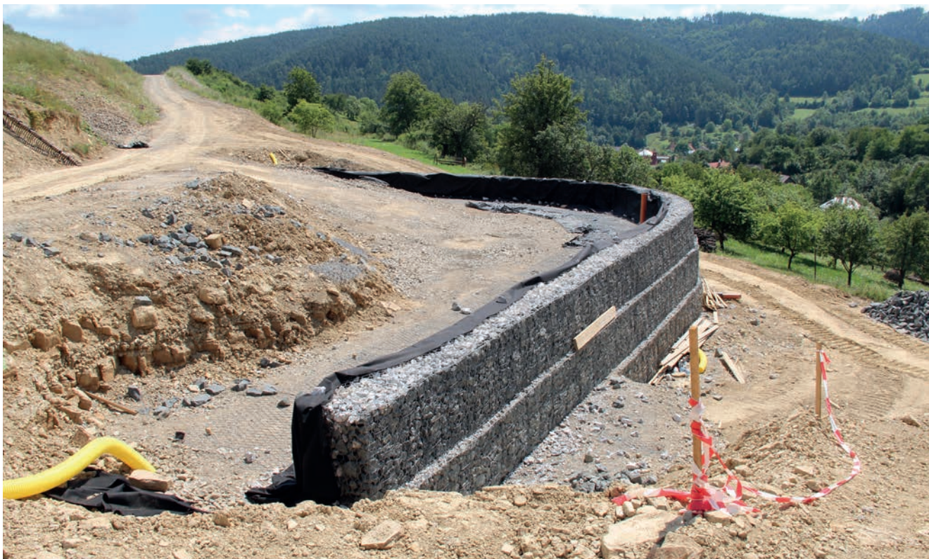
Obr. 3 – Obj. 202-00 opora 5 vo výstavbe
