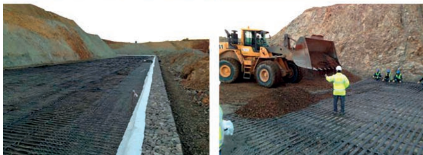
Obr. 8 – Rôzne etapy výstavby
