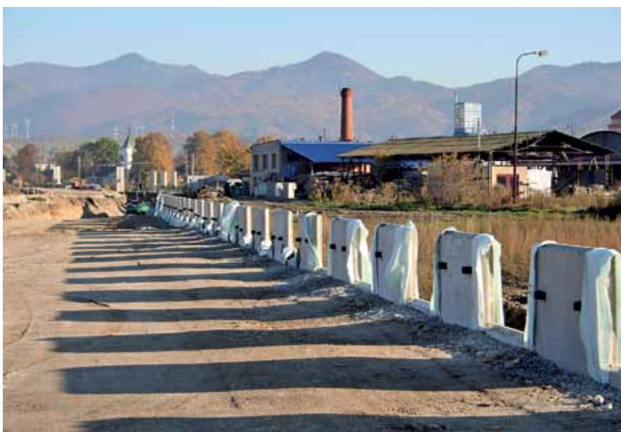
Obr. 7 Prvý rad panelov, oporný múr objektu 235-00
