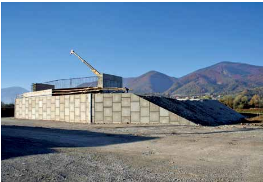
Obr. 6 Mostná opora objektu 207-00
