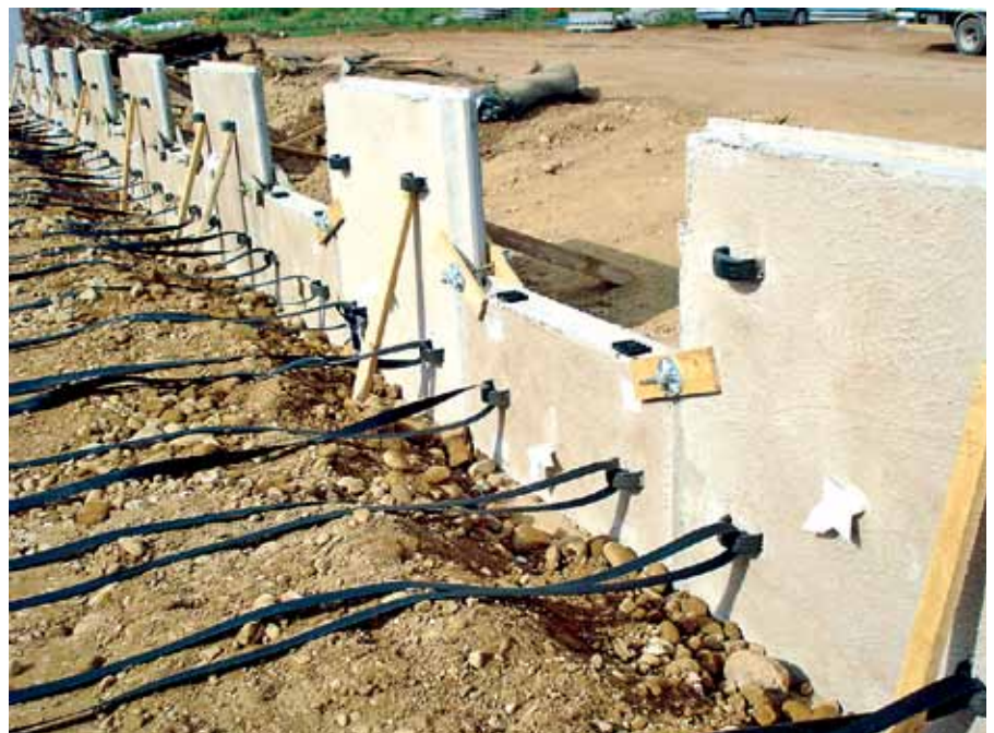
Obr. 4 Detail uchytenia geopásu (Paraweb) na pohľadový múr pomocou spojov Paraloop
