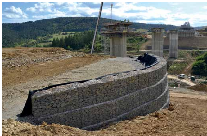
Obr. 11 Násyp pre oporu č. 1
