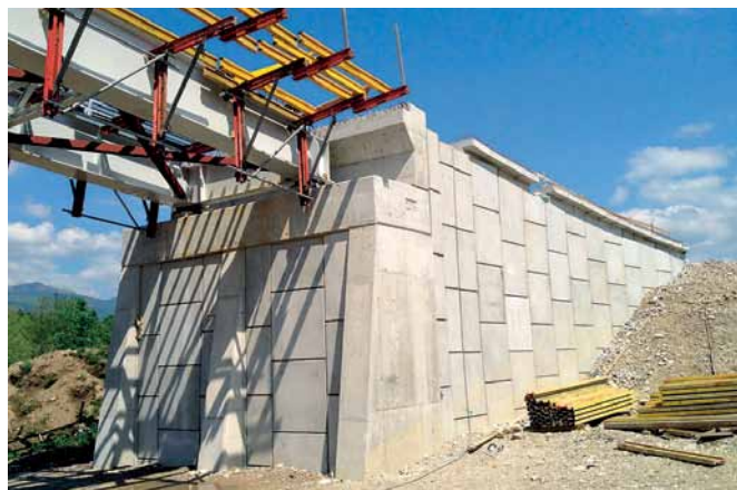
Obr. 6 Oporné múry tvoria rampy prístupovej cesty 142-00, ktorá prechádza ponad diaľnicu D1 mostom 212-00, a dosahujú maximálnu výšku 12,0 m.
