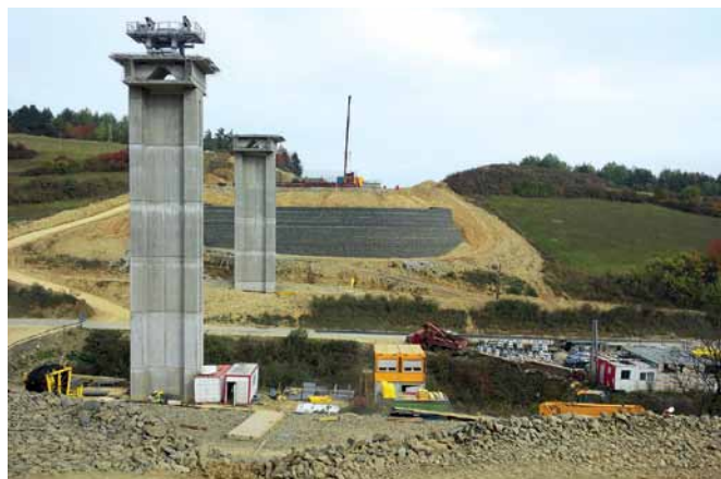
Obr. 12 Pohľad na násyp od opory č. 5
