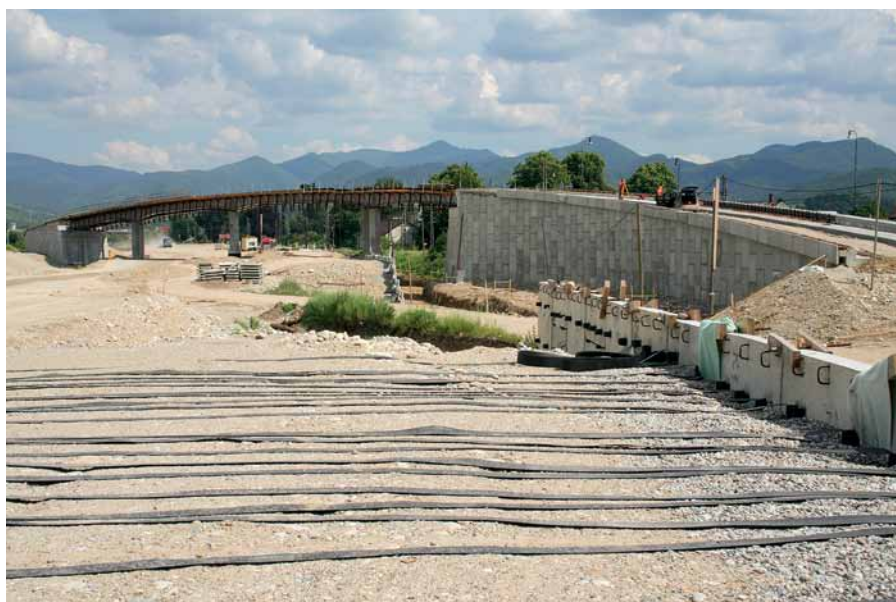
Obr.1 Pohľad na systém vystuženia, v pozadí objekt SO230-00
