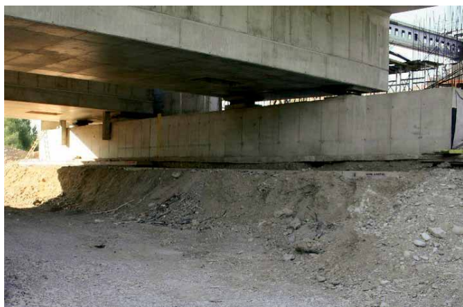
Obr. 13 Stav po odkopaní opory
