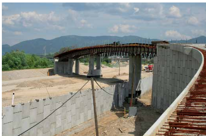
Obr. 7 Oporné múry tvoria krídla opory mostného objektu 212-00.
