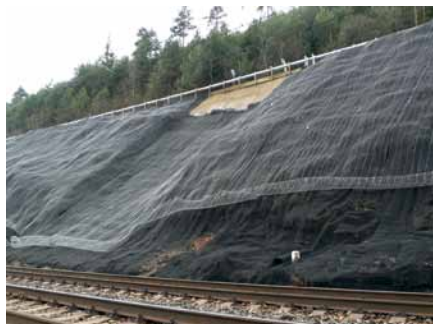
Obr. 1 Pohľad na rozprestretú sieť pred prichytávaním zemnými klinkcami
