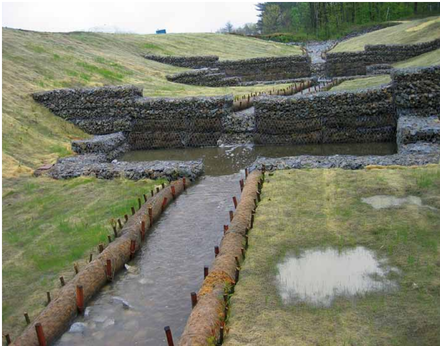
Obr. 6 Odrezky vložené medzi gabionové vrstvy
