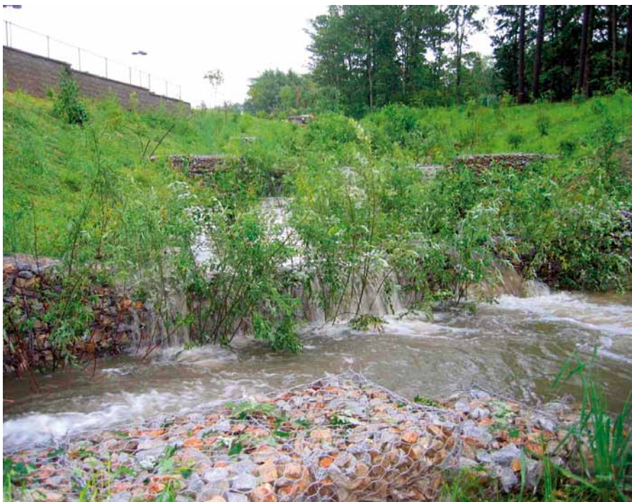
Obr. 7 Hať po dokončení stavby za jedno vegetačné obdobie
