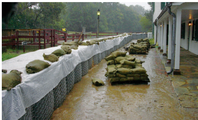
Obr. 2 Bloky FlexMac® DT sa využili aj pri ochrane historickej budovy Great Falls, Washington DC, USA. Hurikán Isabel vtedy spôsobil zvýšenie hladiny rieky Potomac.
