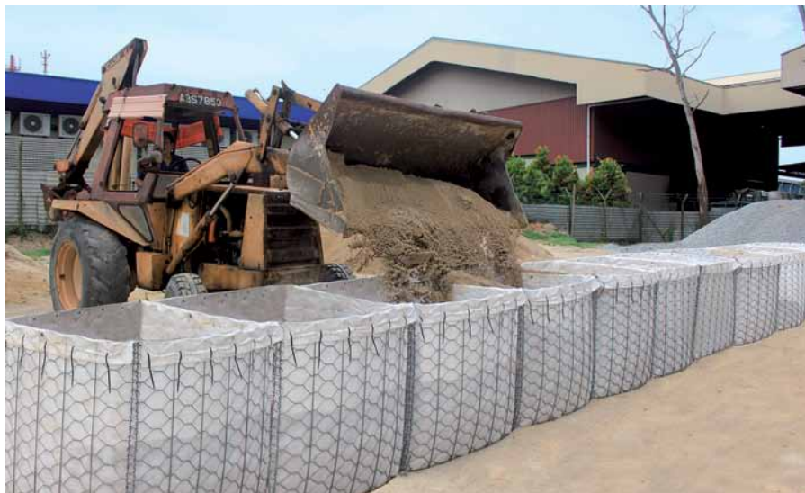
Obr. 9 Plnenie mnohobunkovej konštrukcie
