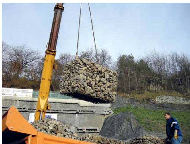
Obr. 7 Manipulácia s prefabrikovaným predplňaným gabionom
