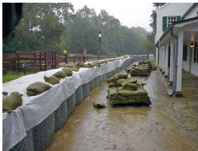
Obr. 8 Použitie mnohobunkovej konštrukcie v praxi
