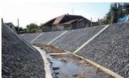
Obr. 5 Reno matrace pri úprave koryta toku v obci Kostoľany pod Tribečom
