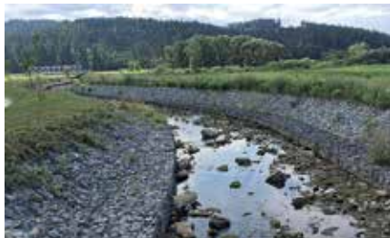
Obr. 4 Reno matrace pri úprave Belianskeho potoka v Spišskej Belé
