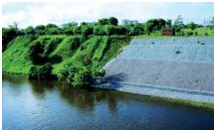
Obr. 3 Aplikácia Reno matracov na stabilizáciu svahu toku
