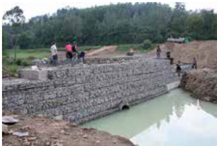
Obr. 7 Výstavba poldra na Ruskinovskom potoku
