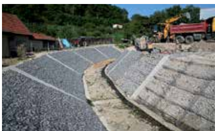
Obr. 5 Reno matrace pri úprave koryta toku v obci Kostoľany pod Tribečom
