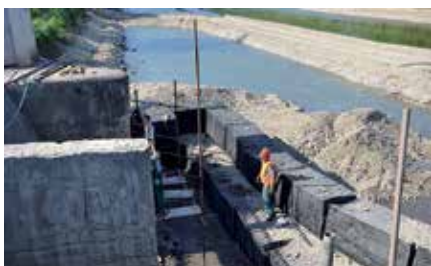
Obr. 6 Inštalácia prefabrikovaných gabionov vo Vyšnom Opátskom
