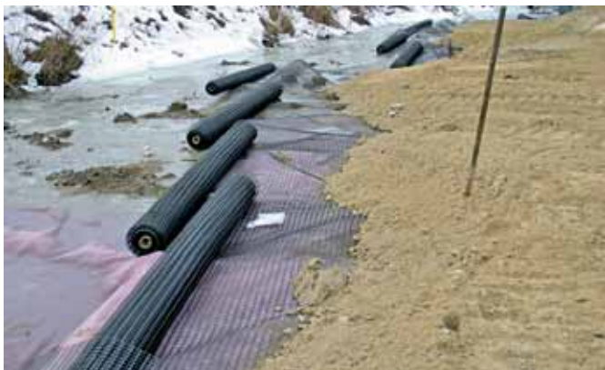
Budovanie technologickej vrstvy na neúnosnom podloží
