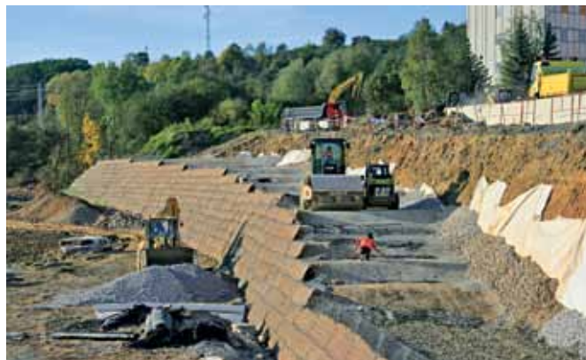
Budovanie zárubného múru konštrukcie Green Terramesh pod areálom SAD
