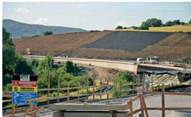
Výstavba ochranného súvrstvia na zárezových svahoch na Kačici
