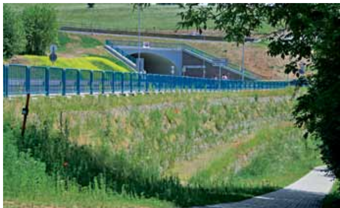
Oporný múr konštrukcie Green Terramesh v Rudlovej po realizácii
