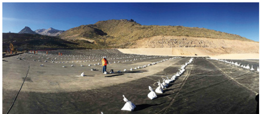
Рис. 9. Панорамный вид хвостохранилища Тамбомайо в процессе укладки геомембраны МакЛайн
