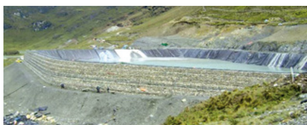
Рис. 2. Хвостохранилище Синаикоха в процессе строительства и по его окончании
