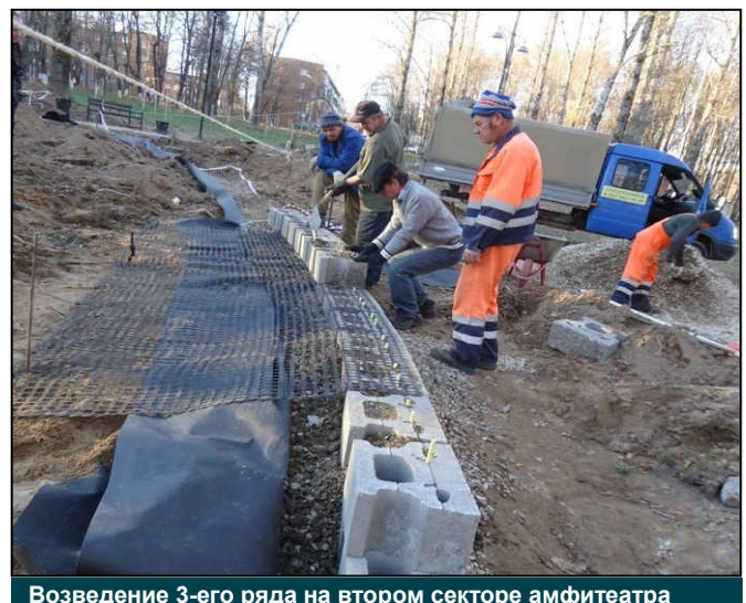
Процесс возведения первых рядов блоков Макволл
