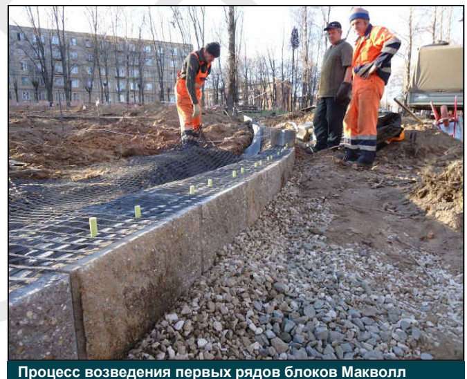
Процесс возведения первых рядов блоков Макволл
