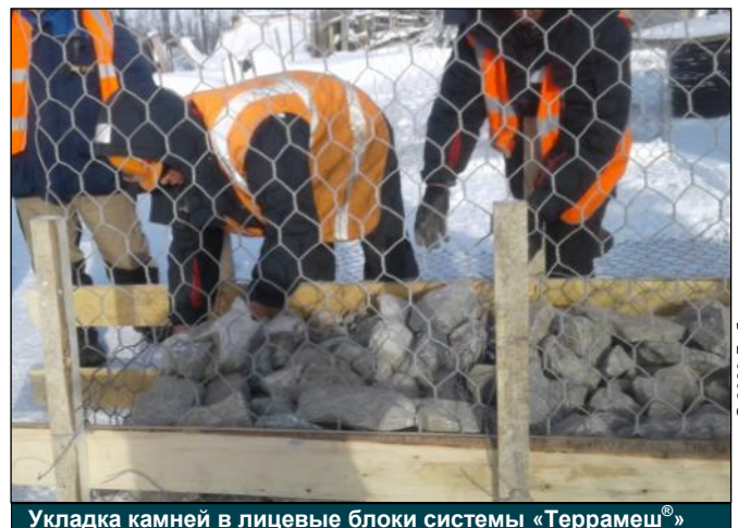
Укладка камней в лицевые блоки системы «Террамеш ® »
