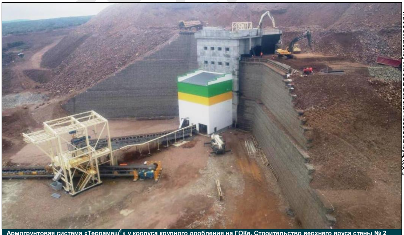
Армогрунтовая система «Террамеш®» у корпуса крупного дробления на ГОКе. Строительство верхнего яруса стены № 2
