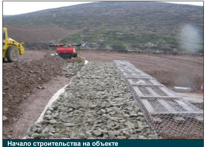
Начало строительства на объекте
