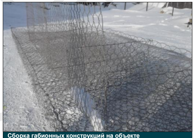
Сборка габионных конструкций на объекте
