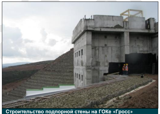
Строительство подпорной стены на ГОКе «Гросс»
