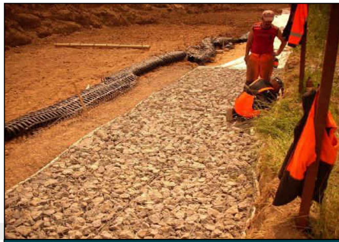
Укладка матраца Рено в основание стенки
