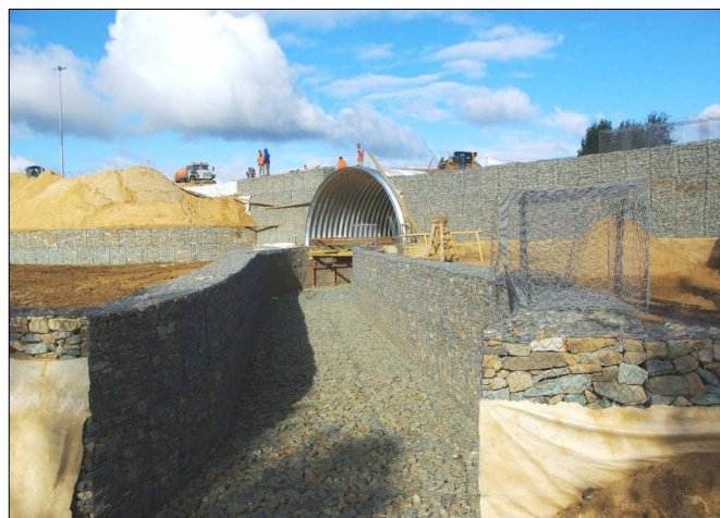
Крепление портала трубы с помощью системы Террамеш
