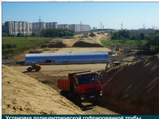
Установка полицентрической гофрированной трубы
