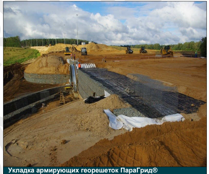
Укладка армирующих георешеток ПараГрид®
