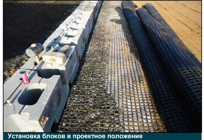
Установка блоков в проектное положение
