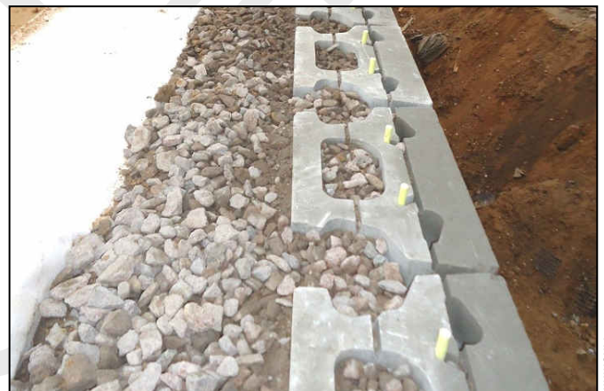
Уплотнение ручной трамбовкой 3-х метров за лицевой гранью
