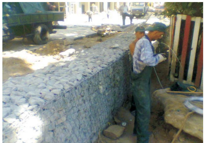
В процессе строительства
