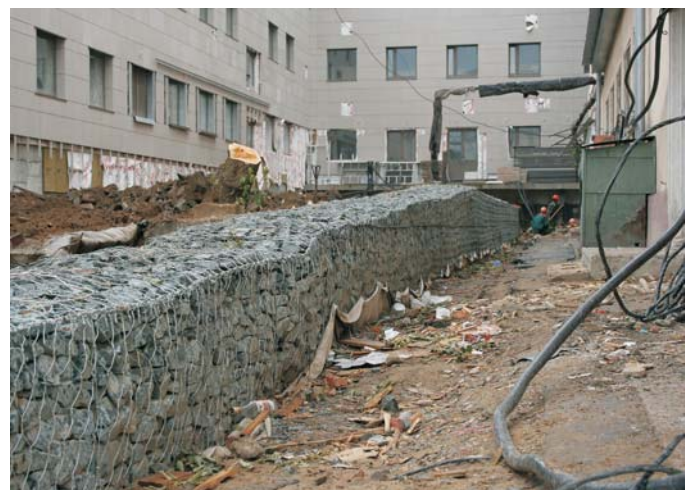
В процессе строительства
