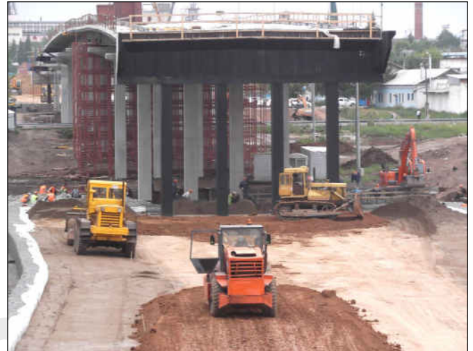
Возведение пролетного строения путепровода
