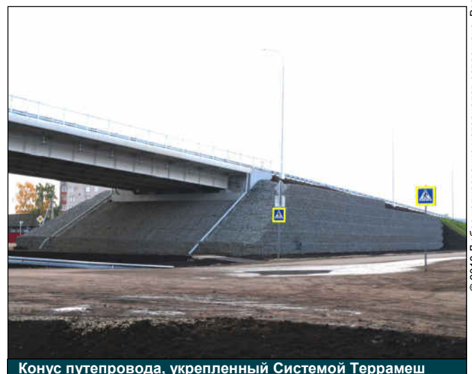
Возведение армогрунтового подхода к путепроводу
