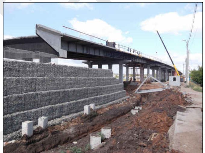
Возведение армогрунтового подхода к путепроводу
