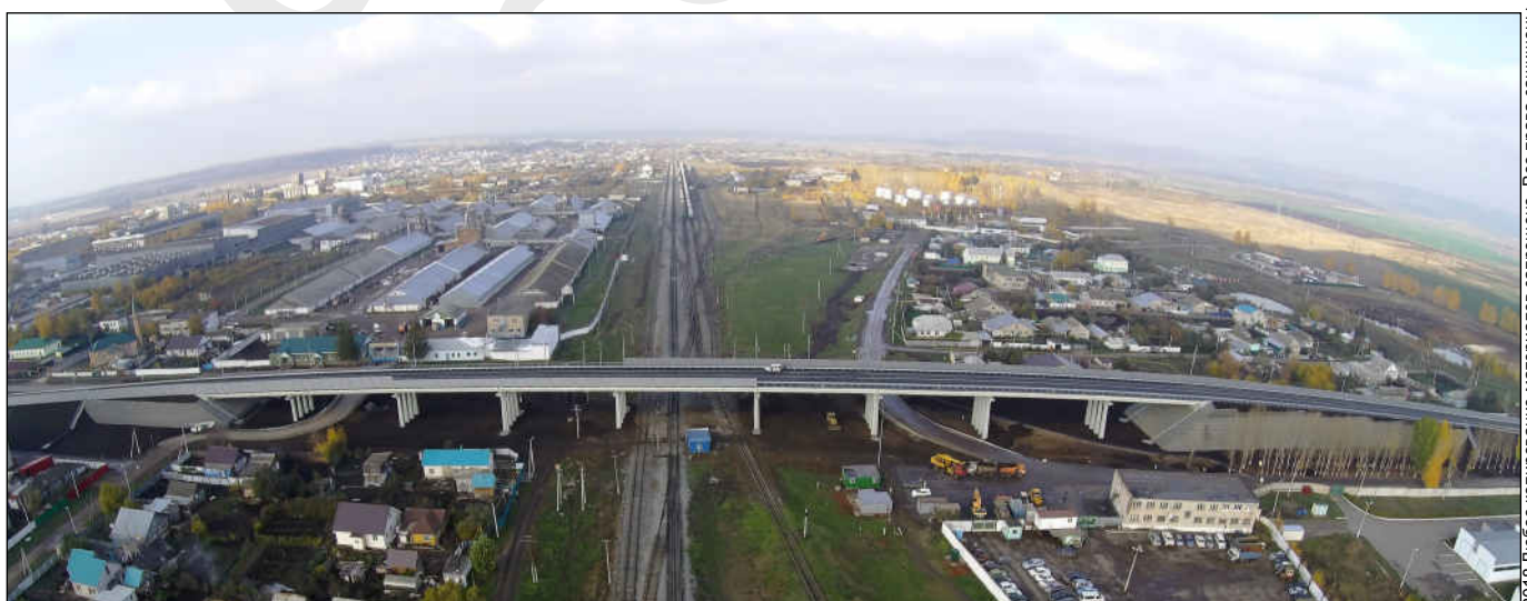
Панорамный вид путепровода с подходами
