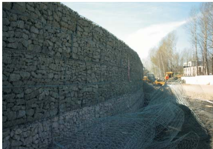
В процессе строительства
