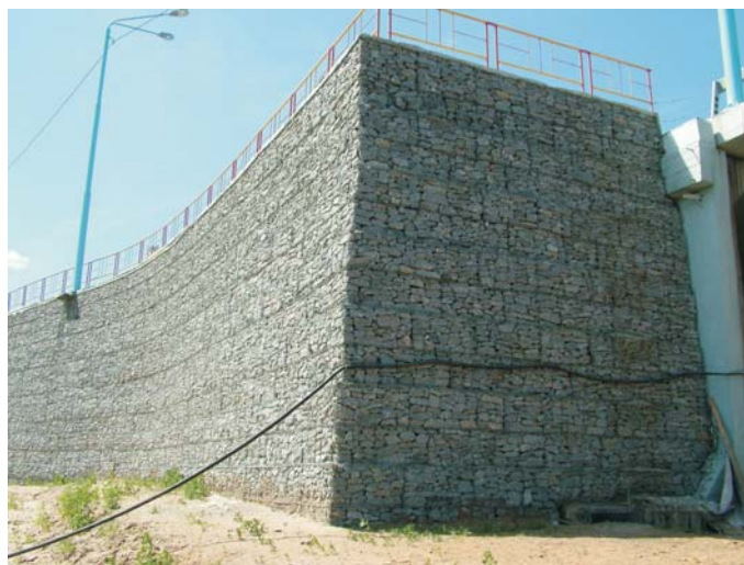
По окончании строительства
