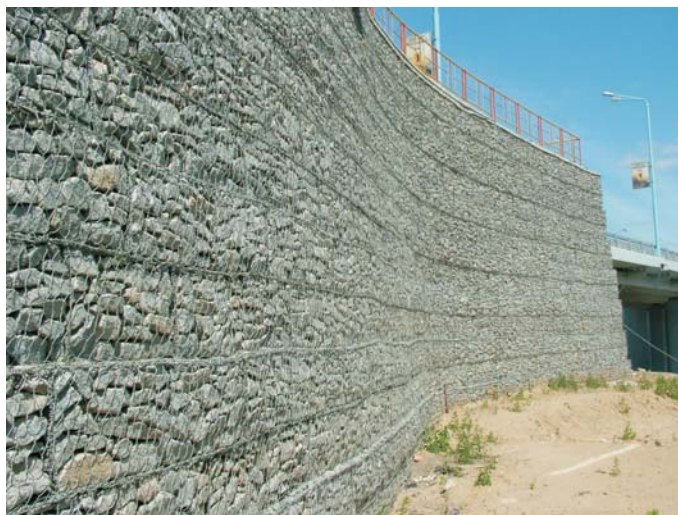
По окончании строительства
