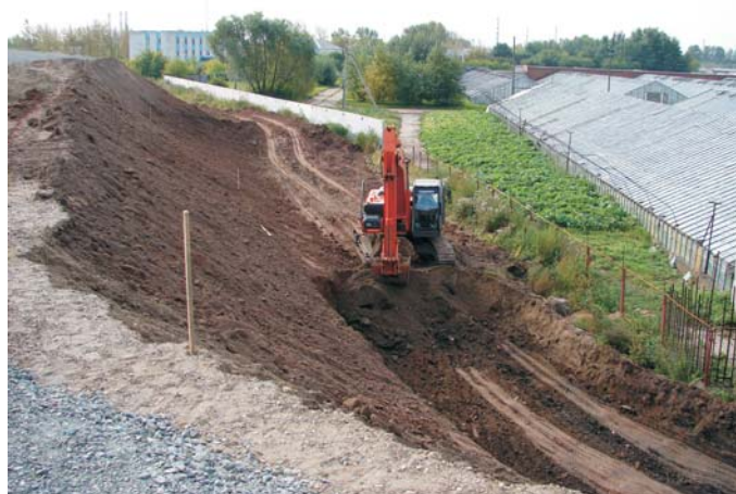
В процессе строительства
