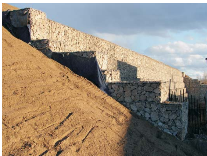
По окончании строительства
