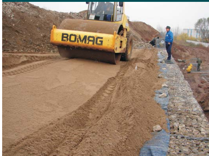
В процессе строительства
