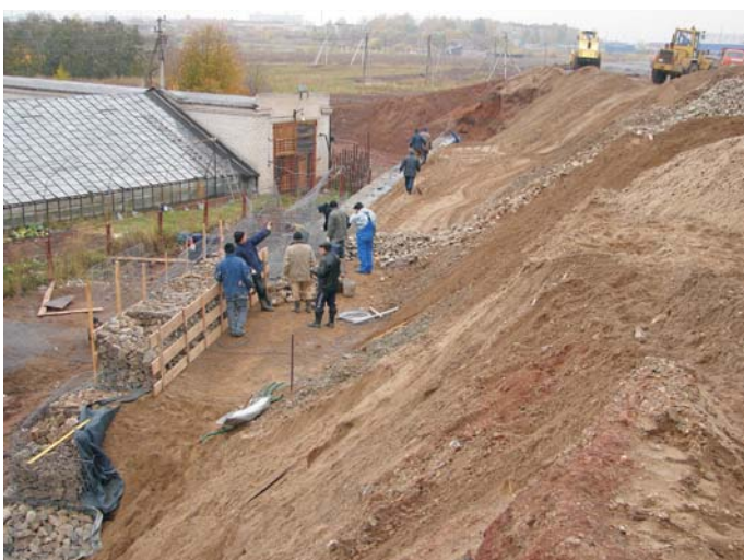
В процессе строительства
