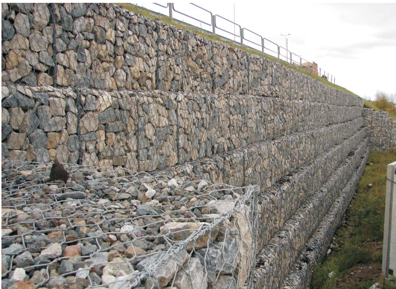
По окончании строительства
