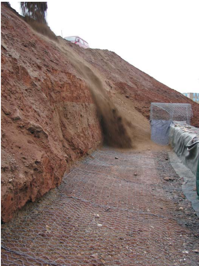
В процессе строительства
