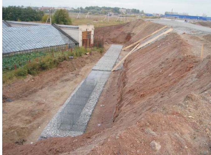
В процессе строительства
