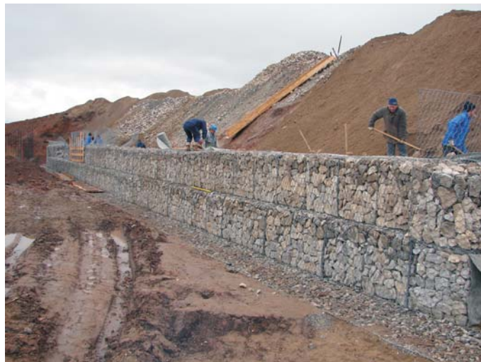
В процессе строительства
