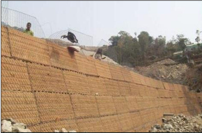
Система Зеленый Террамеш в процессе сборки
