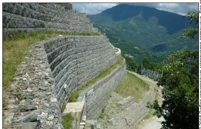
Армогрунтовая конструкция почти в полную высоту
