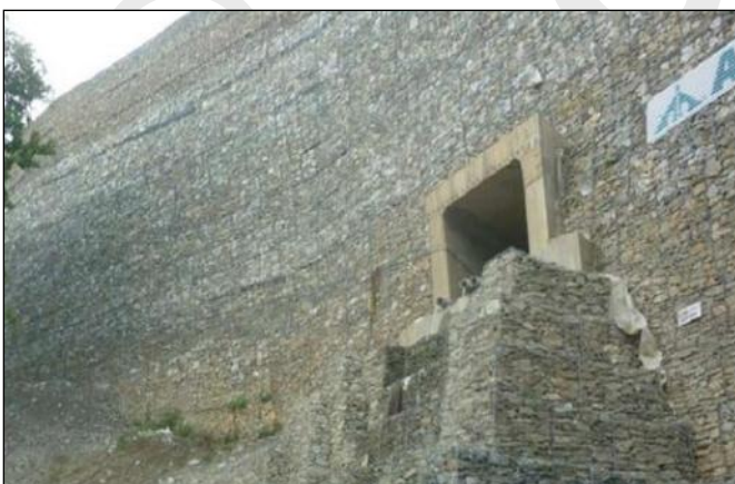
Водопропускная труба для джхор и перепад из габионов
