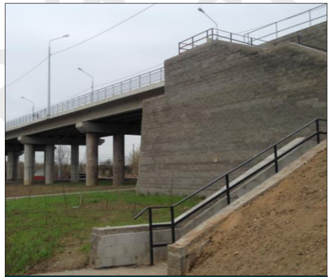
Конус путепровода в конце строительства
