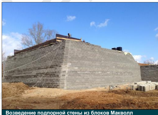
Возведение подпорной стены из блоков Макволл
