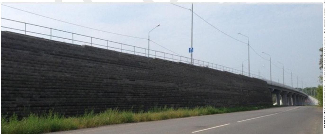
Общий вид путепровода
