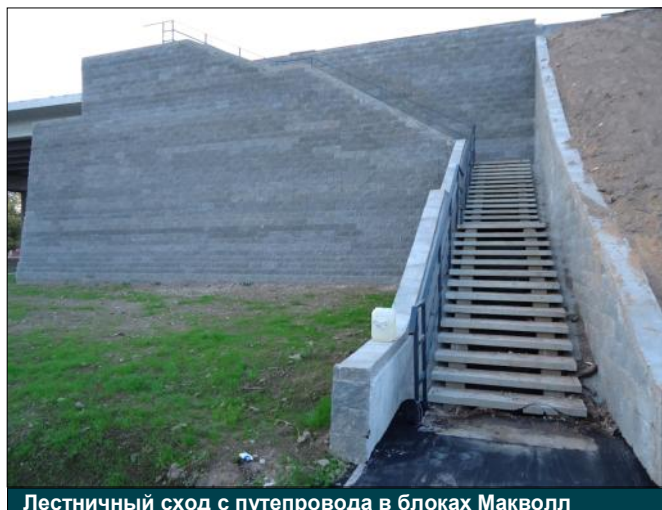
Лестничный сход с путепровода в блоках Макволл
