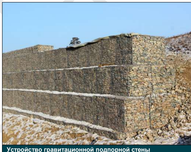
Устройство гравитационной подпорной стены
