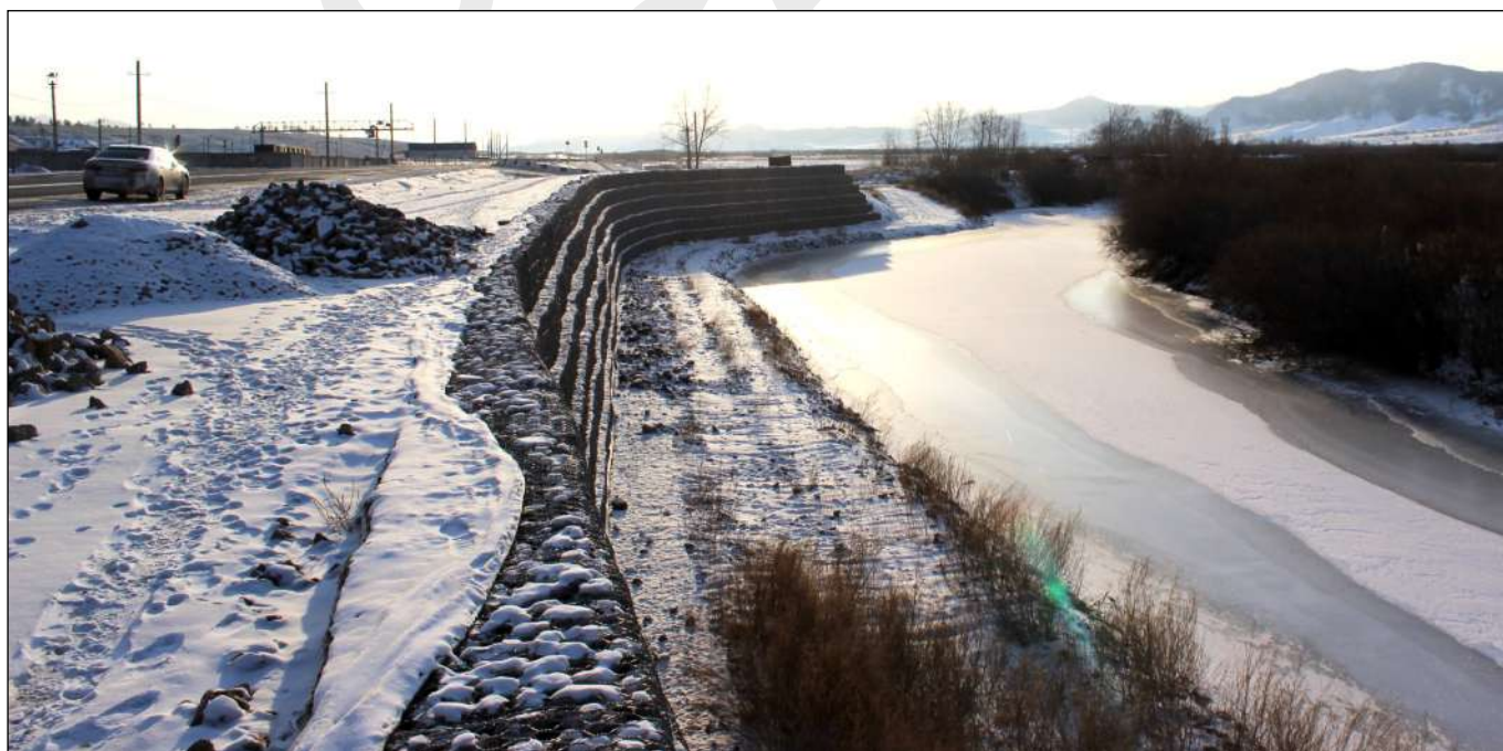
Готовая армогрунтовая Система Террамеш® вдоль берега реки Селенга
