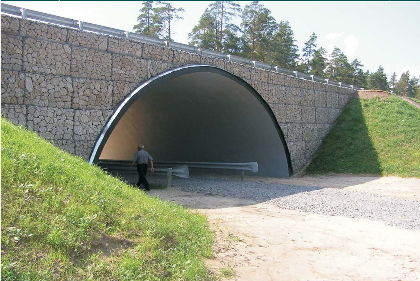
По окончании строительства
