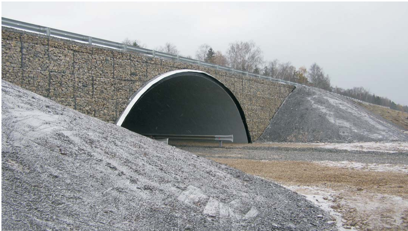
По окончании строительства
