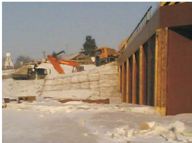
В процессе строительства
