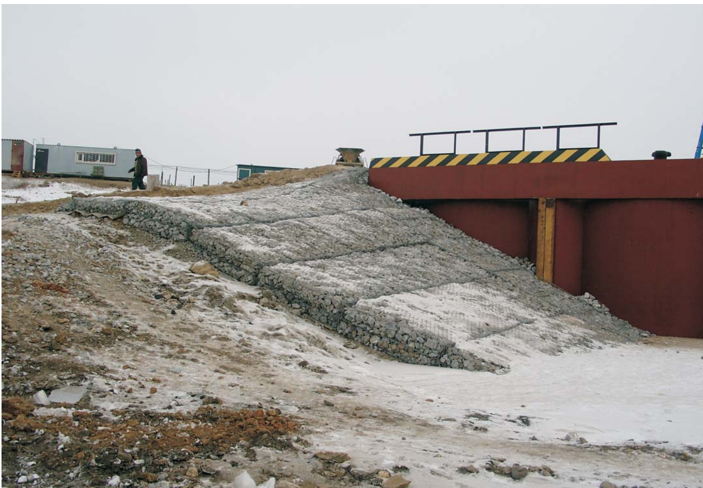
По окончании строительства
