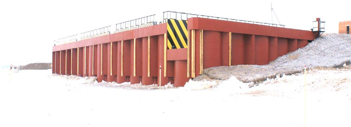
В процессе строительства
