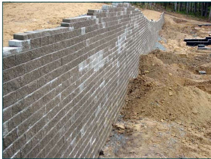
По окончании строительства
