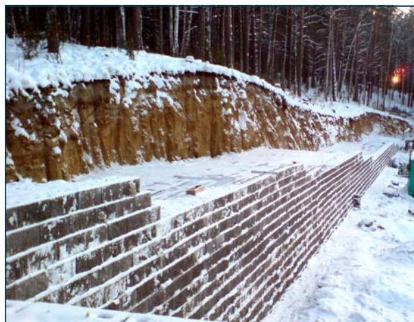
В процессе строительства
