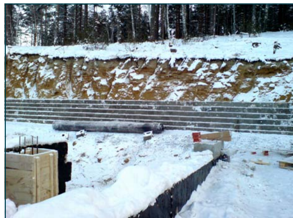
В процессе строительства
