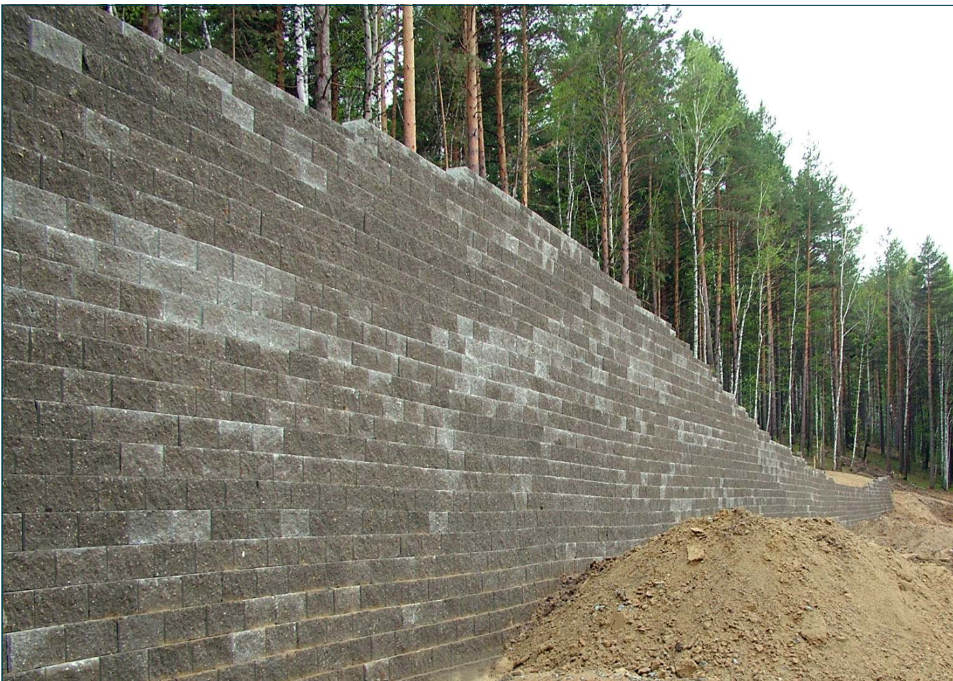
По окончании строительства
