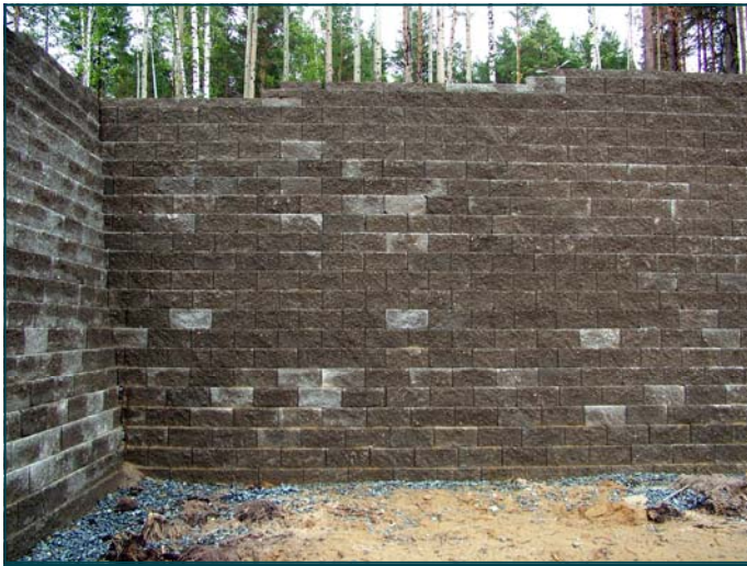
По окончании строительства
