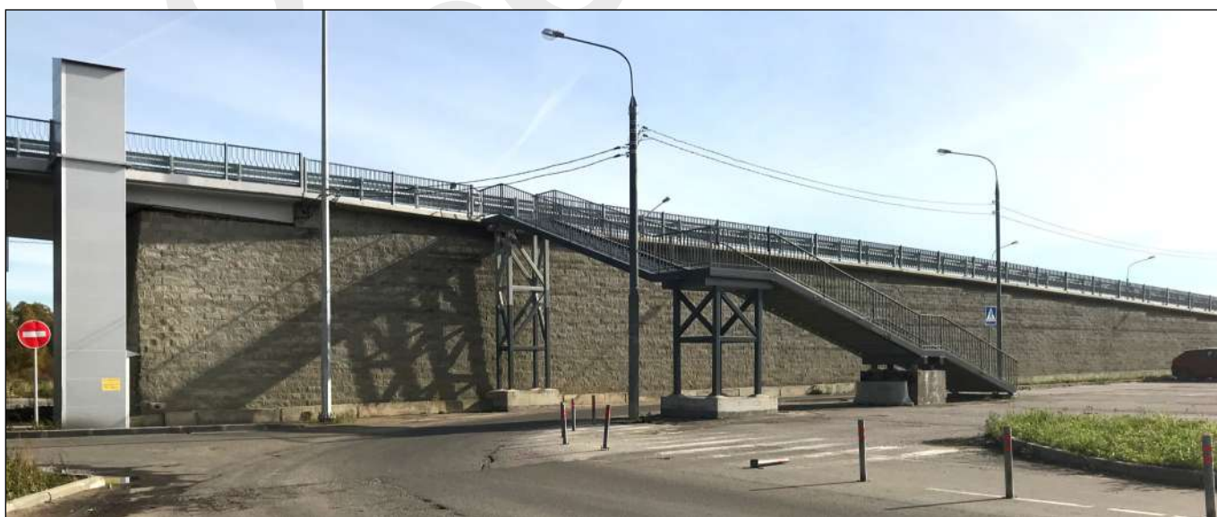
Общий вид подхода к путепроводу
