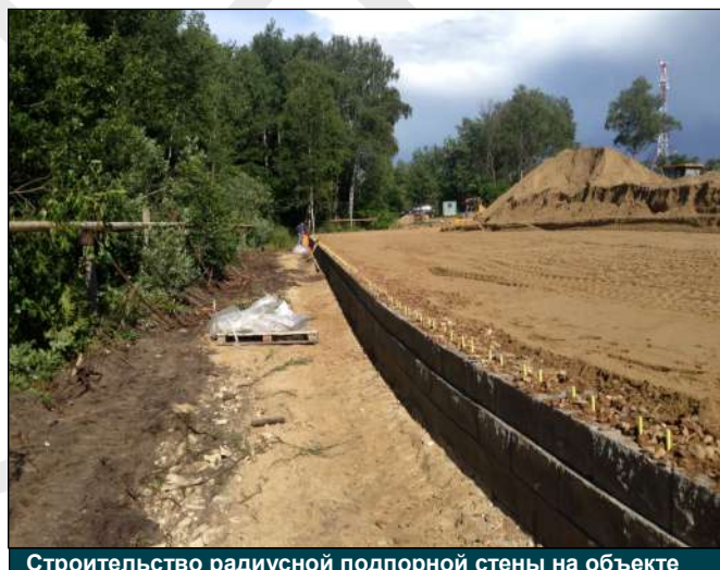
Строительство радиусной подпорной стены на объекте
