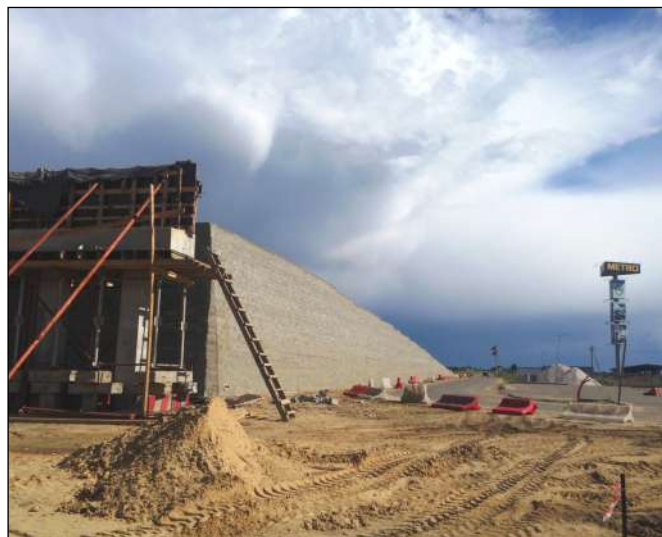
Строительство П-образного подхода к путепроводу
