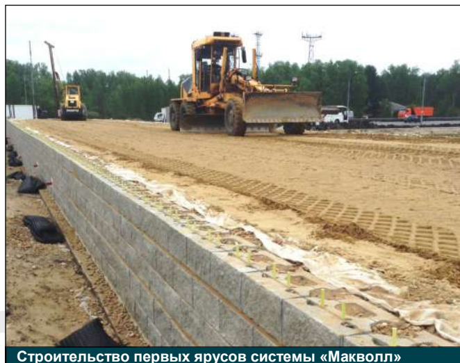
Строительство первых ярусов системы «Макволл»
