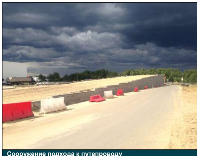
Сооружение подхода к путепроводу
