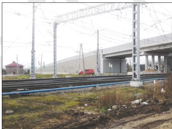
Конструкция путепровода в конце строительства
