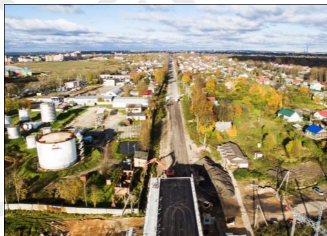
Сооружение подходов к путепроводу
