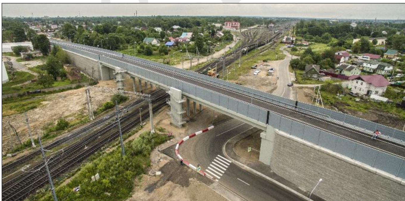
Общий вид путепровода
