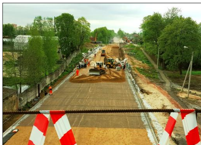
Сооружение армогрунтовой насыпи системы Макволл
