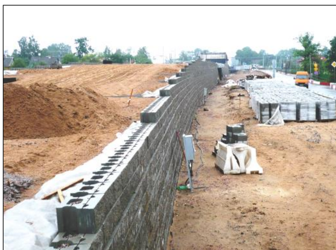
Подпорная стена из сегментных блоков Макволл
