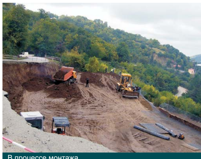
В процессе монтажа
