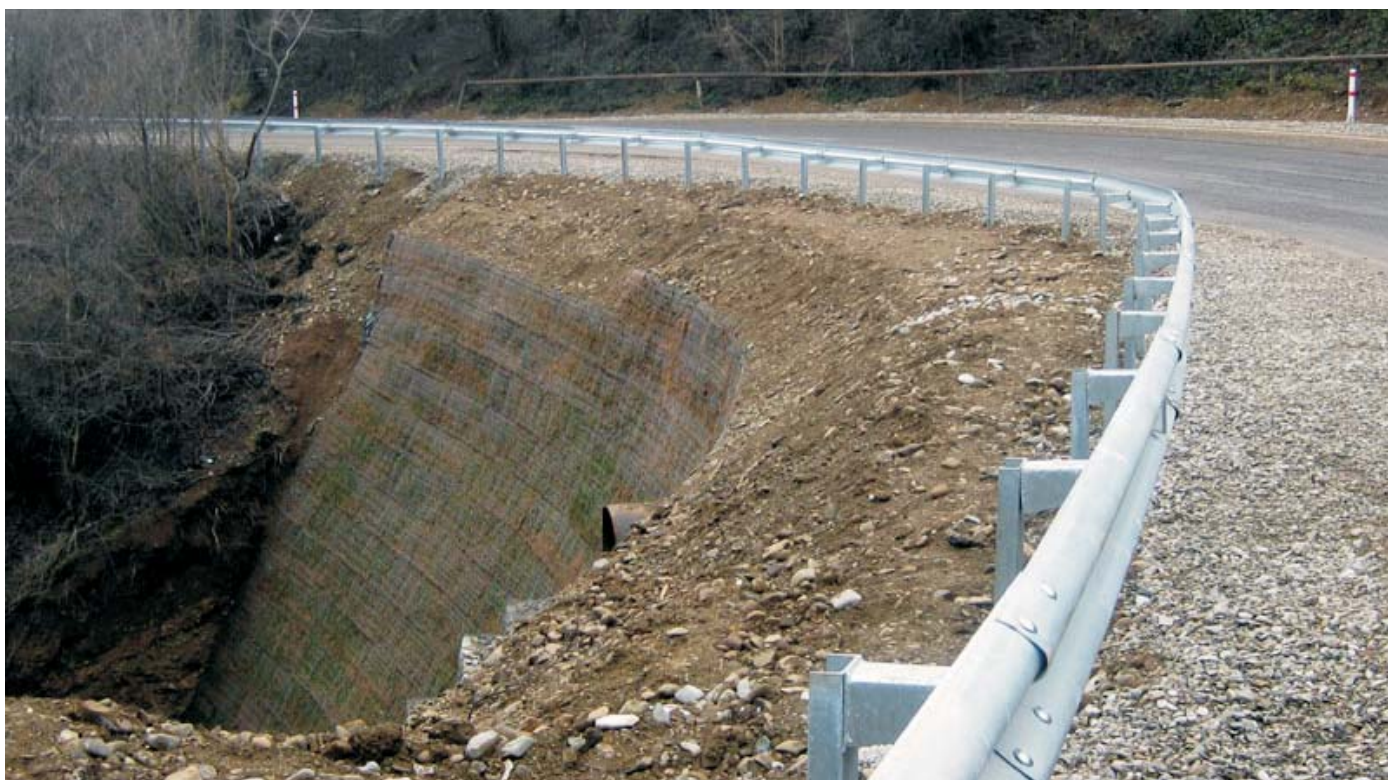
По окончании строительства
