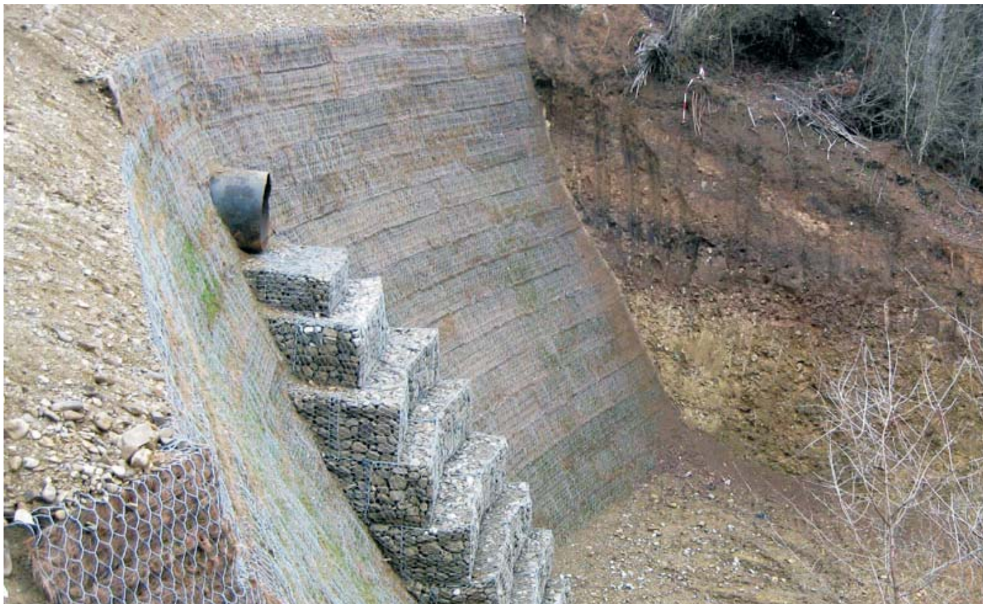
По окончании строительства
