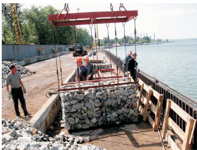
В процессе строительства
