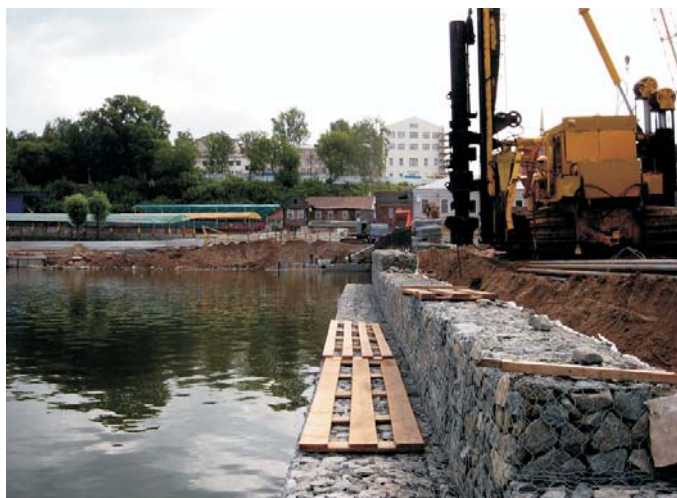
В процессе строительства
