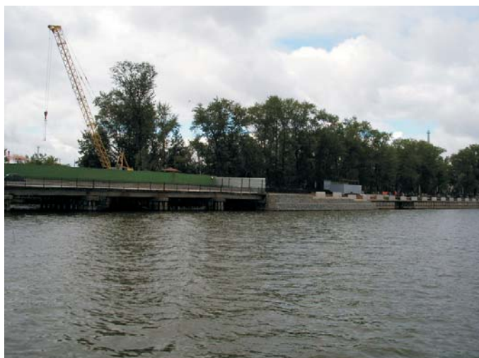
По окончании строительства
