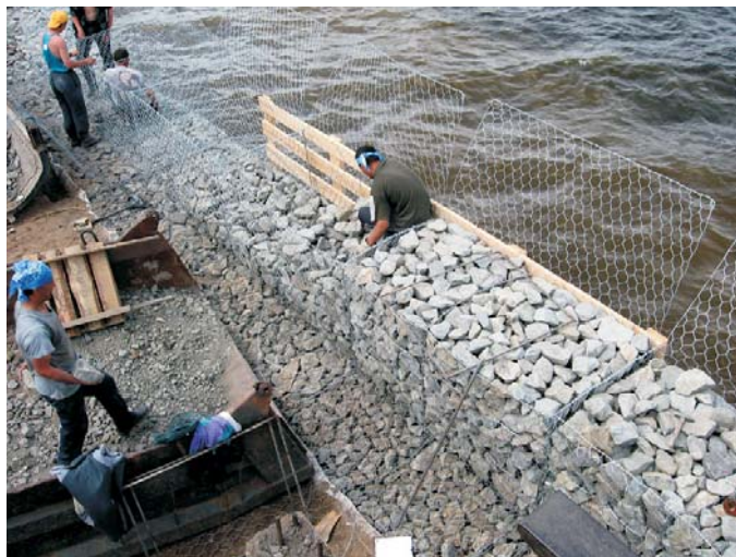
В процессе строительства
