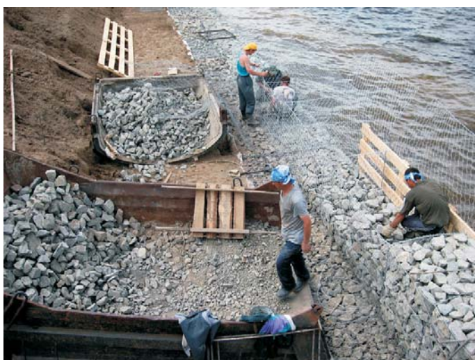
В процессе строительства
