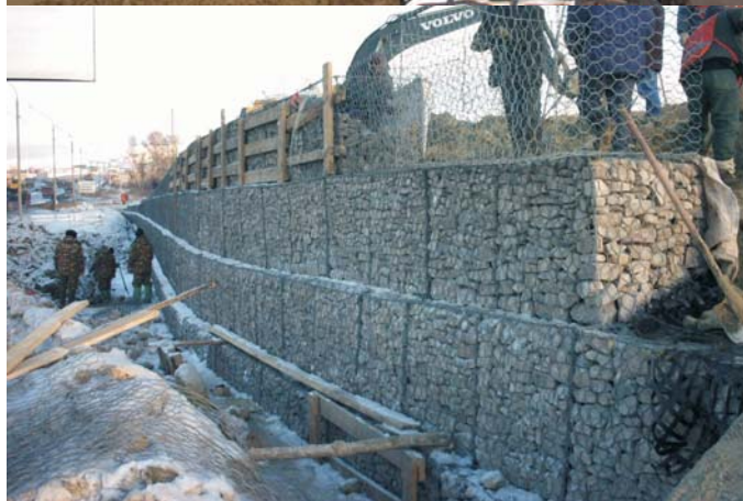
В процессе строительства
