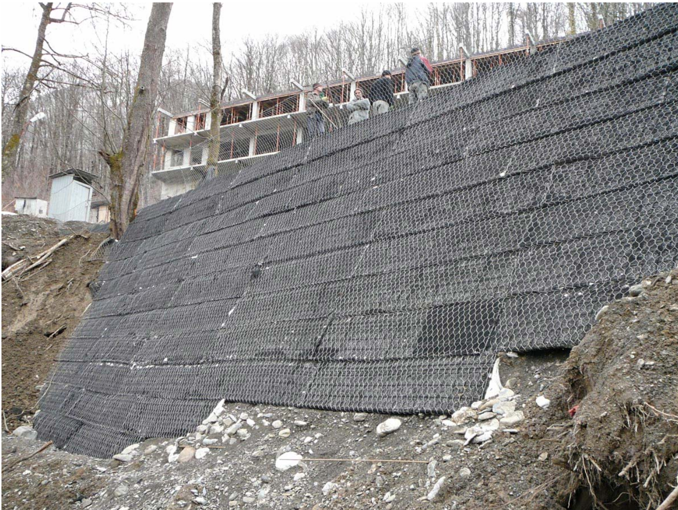
В процессе строительства
