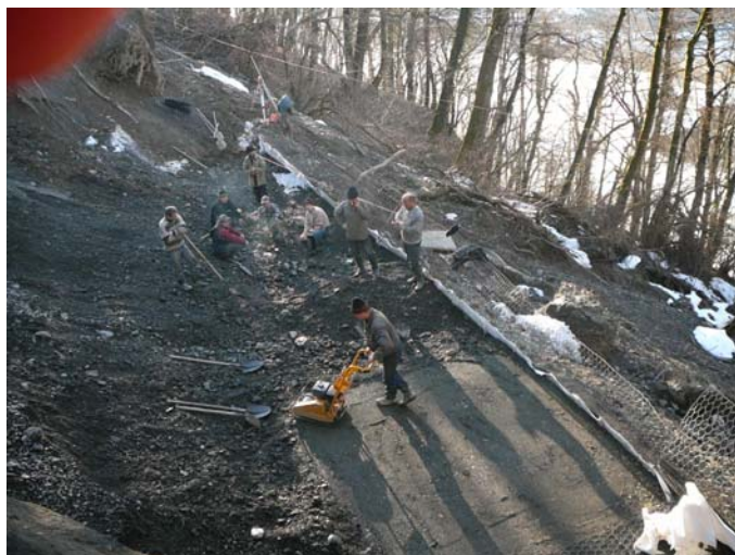
В процессе строительства
