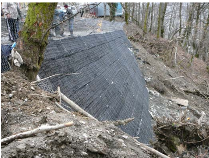
В процессе строительства
