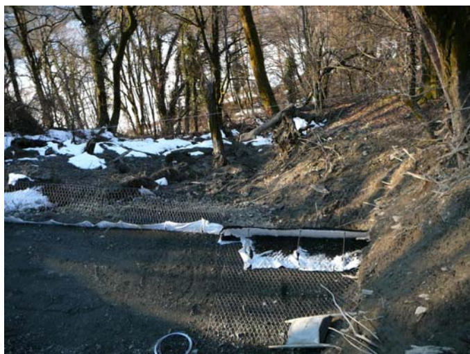
В процессе строительства
