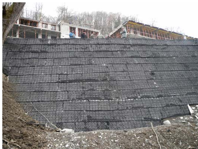
По окончании строительства
