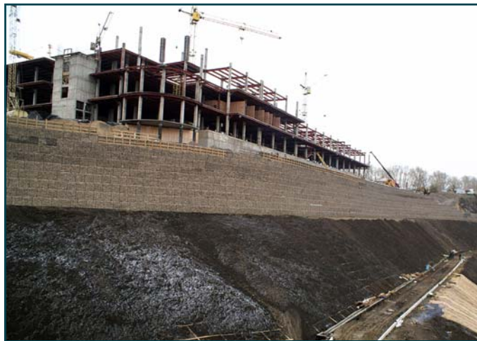
В процессе строительства
