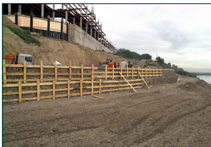
В процессе строительства
