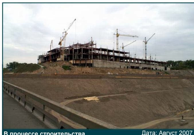
В процессе строительства
