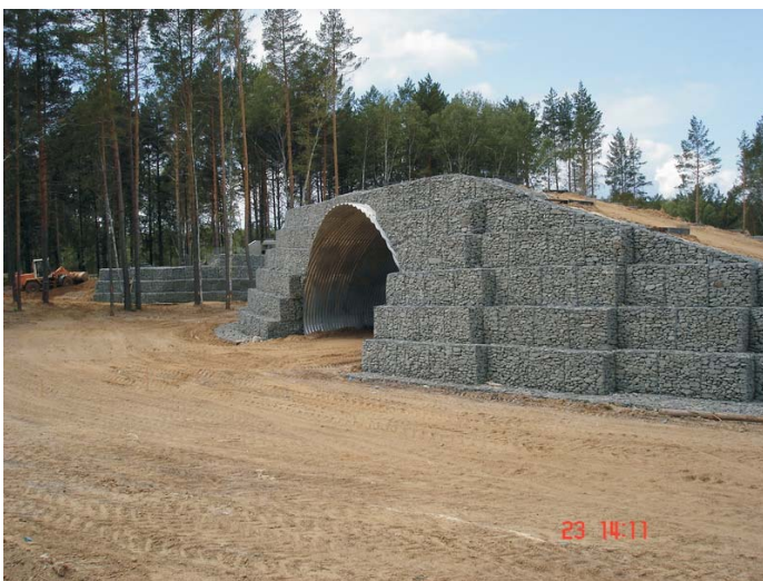
По окончании строительства
