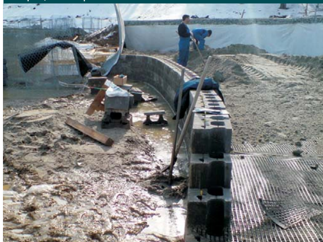
В процессе строительства
