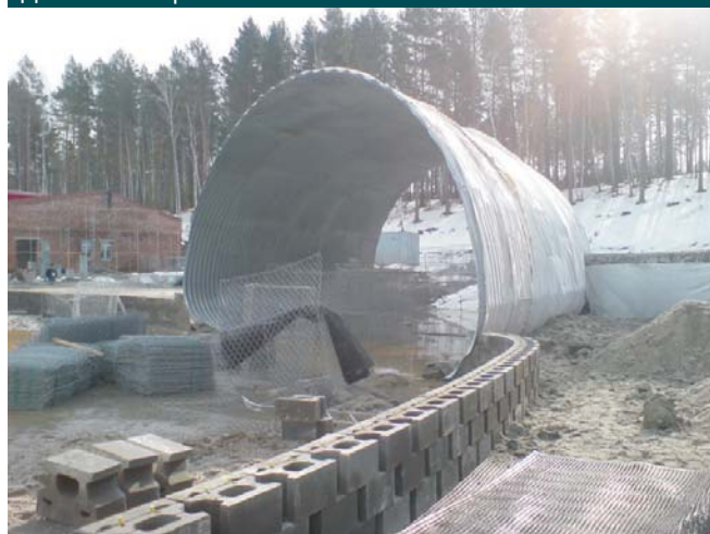
В процессе строительства
