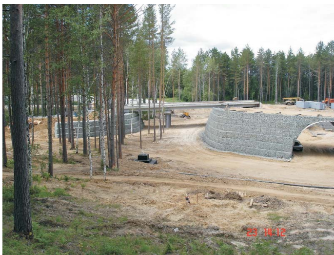
По окончании строительства
