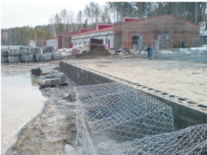
В процессе строительства
