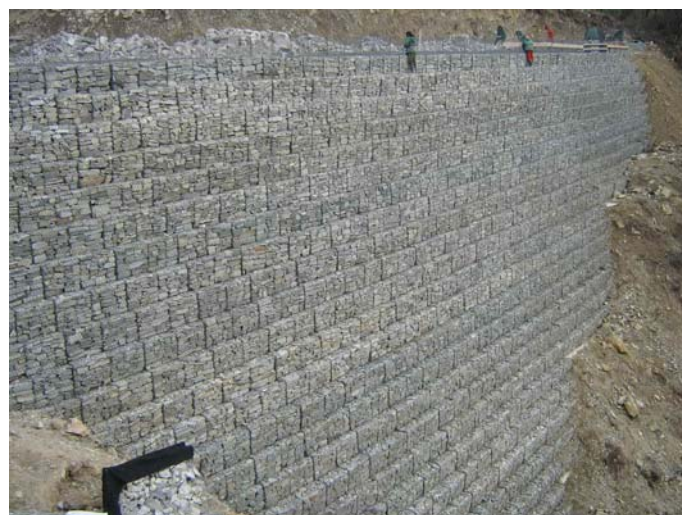
В процессе строительства
