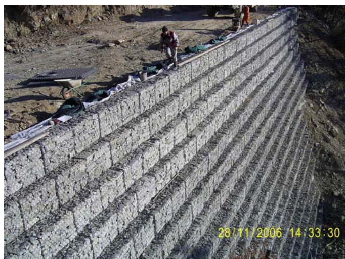
В процессе строительства
