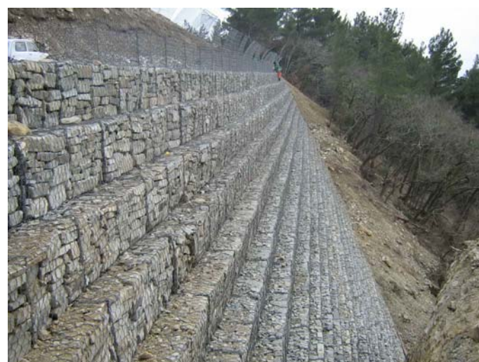
В процессе строительства
