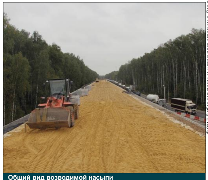
Общий вид возводимой насыпи
