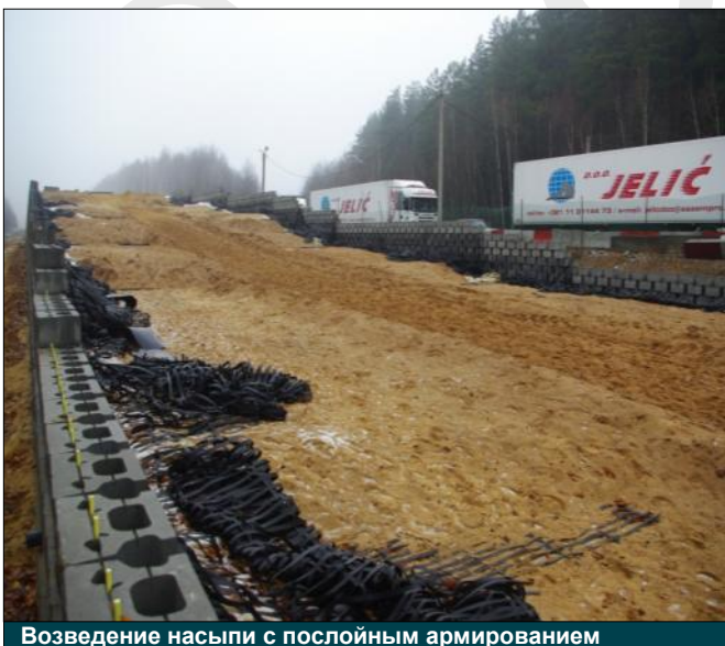
Возведение насыпи с послойным армированием
