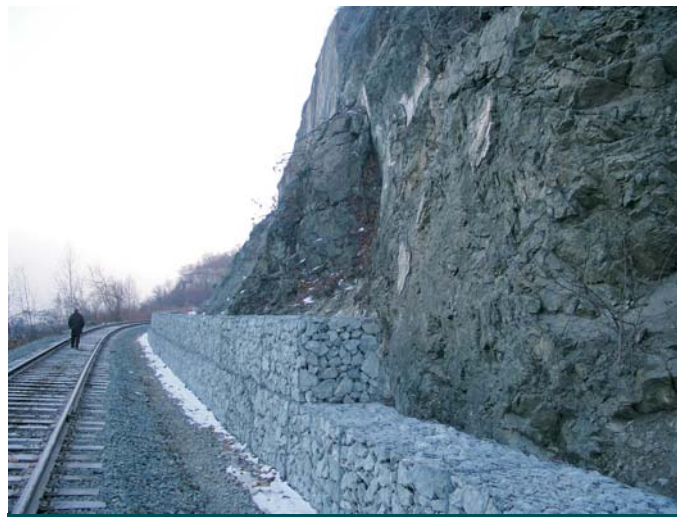
В процессе строительства
