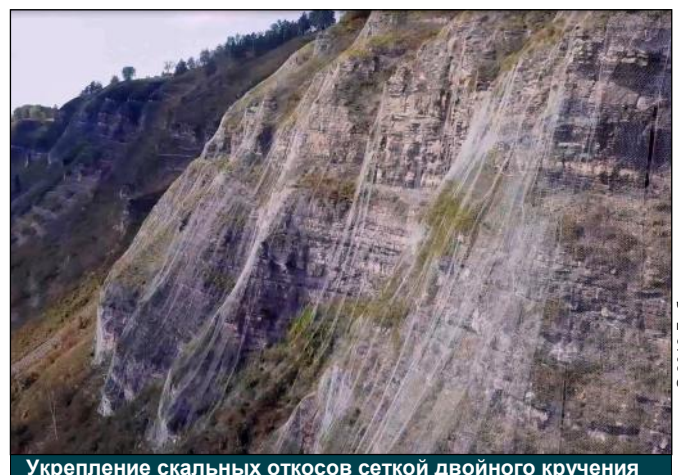
Укрепление скальных откосов сеткой двойного кручения
