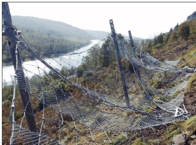
Монтаж снегоудерживающих барьеров на склоне
