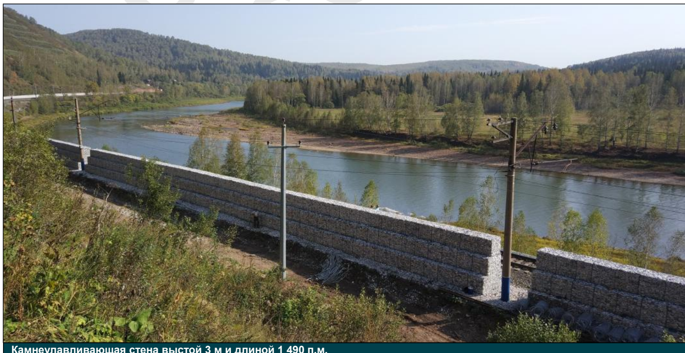
Камнеулавливающая стена высотой 3 м и длиной 1 490 п.м.
