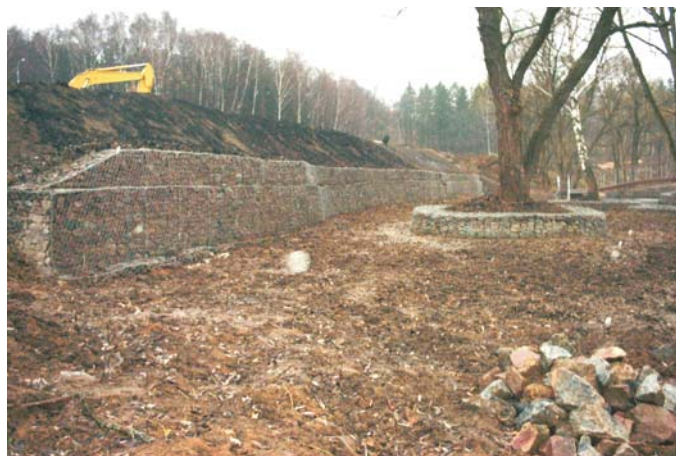
В процессе строительства
