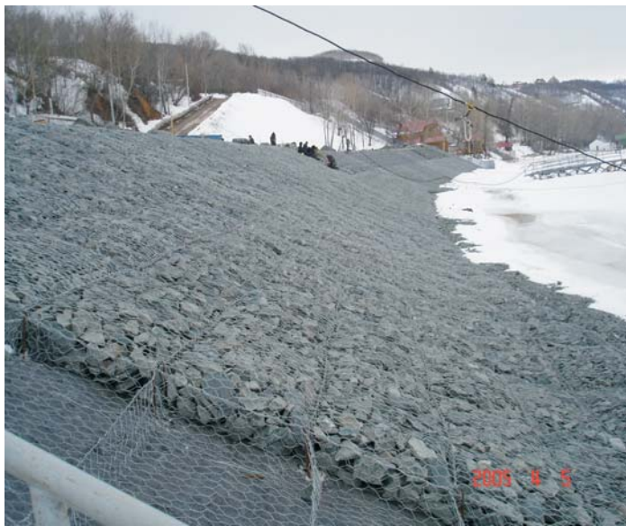
В процессе строительства
