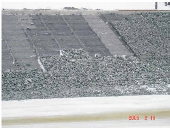
В процессе строительства
