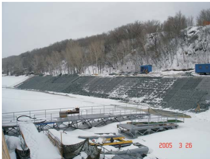
В процессе строительства
