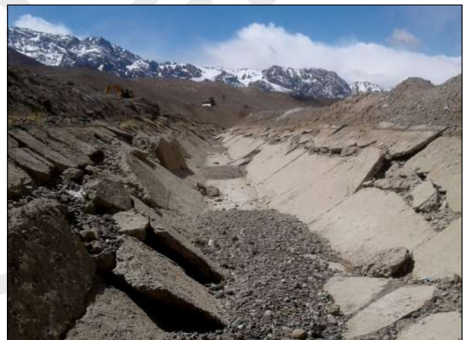
Деривационный канал ГЭС «Аксу» до реконструкции
